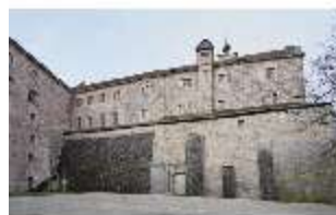
KuPla.I, Kasernenhof (Niederburg), DI025713, BSV
