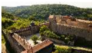
KuPla.I, Luftaufnahme aus Norden, Kasernenhof, DI027873, BSV-
