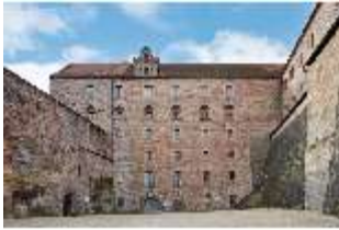
KuPla.I, Fassade vom Arsenalbau, Kasernenhof, DI025706, BSV
