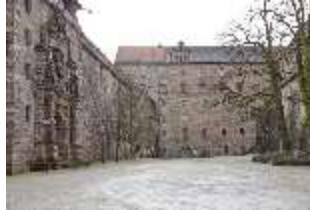
KuPla.I, Fassade vom Arsenalbau, Kasernenhof, DI025707, BSV
