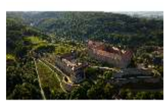
KuPla.I, Luftaufnahme aus Norden, DI027869, BSV-
