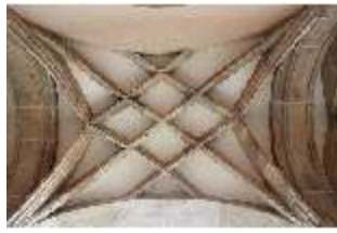
KuPla.I, Südflügel, 2. Joch, 1. OG, Rippengewölbe, DI017510, BSV-
