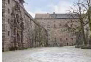
KuPla.I, Fassade vom Arsenalbau, Kasernenhof, DI025708, BSV
