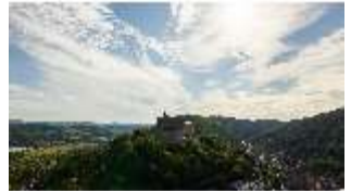
KuPla.I, Luftaufnahme, Blick von Westen, DI027868, BSV-
