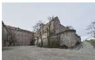
KuPla.I, Kasernenhof (Niederburg), DI025712, BSV
