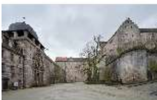
KuPla.I, Kasernenhof (Niederburg), DI025711, BSV
