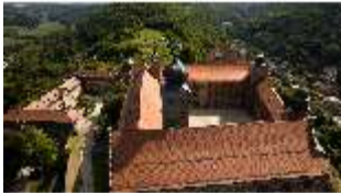
KuPla.I, Luftaufnahme, Blick aus Westen, DI027876, BSV-
