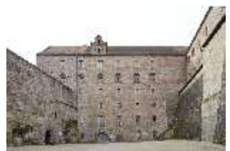
KuPla.I, Fassade vom Arsenalbau, Kasernenhof, DI025705, BSV
